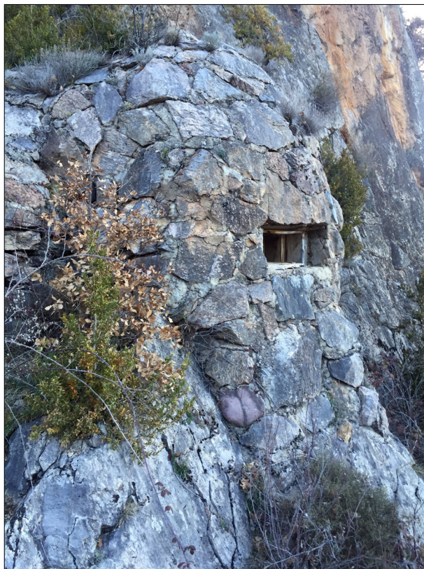
FIG. 9. Tronera del búnker excavado en La Roca de la Mel, perteneciente al núcleo de resistencia de Martinet, Lérida. Fotografía del autor.
