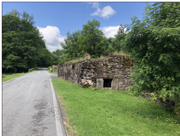
FIG. 15. Posición de artillería en la carretera del collado de Izpegui, Navarra; camuflada como casa o cabaña. Nótese el recubrimiento de piedra, el tejado a dos aguas, la chimenea y una chapa que simula la piedra para disimular la tronera. Este fuerte camuflaje se debe a la cercanía a la carretera y al núcleo de población. Fotografía del autor.
