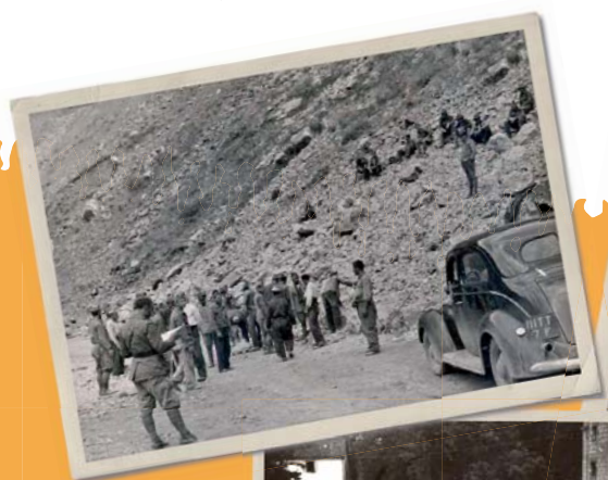
Pola de Gordón (León). 1937. Prisioneros vascos trabajando en la construcción de una carretera.
