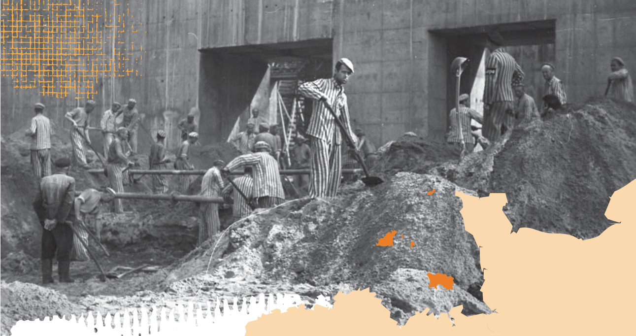
Bremen (Alemania). 1944. Trabajadores forzados en la construcción de una base submarina. Bundesarchiv. Bild 185-10-21A.
